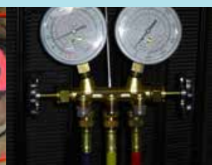
Analizador (tres mangueras, manovacuómetro de baja y manómetro de alta)
